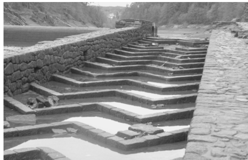
Obr. 4: Retardérová vorová propust na jezu u Nového mlýna z r. 1929.
