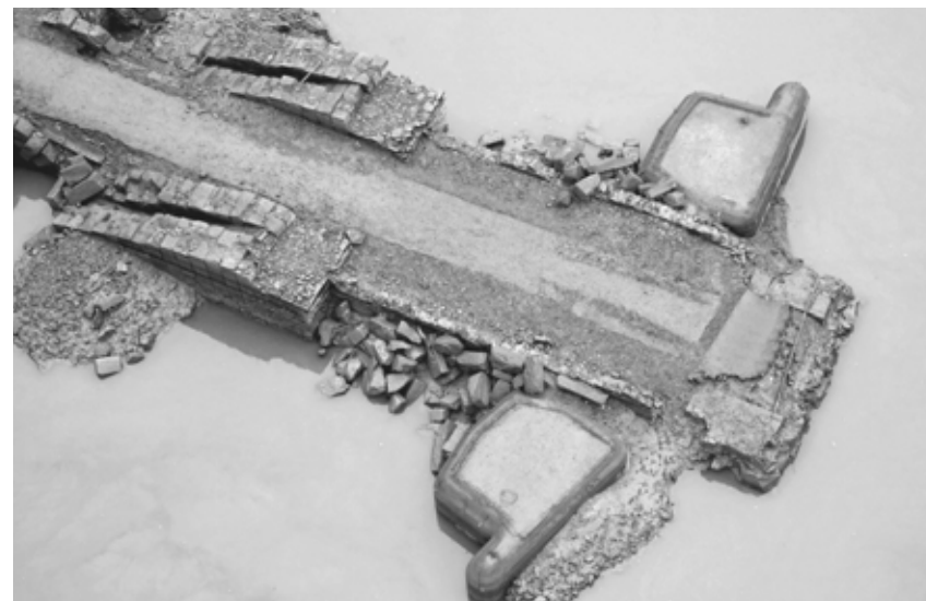
Obr. 8: Nájezd na podolský řetězový most a základy pro pilíře na pravém břehu. Most byl postaven v letech 1847 – 1848 a před napuštěním přehrady byl rozebrán.
