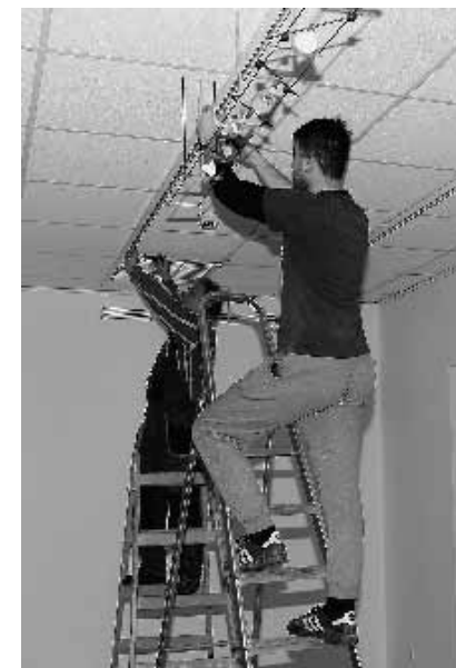
Deinstalace starého osvětlení v Galerii. Foto V. Komasová
