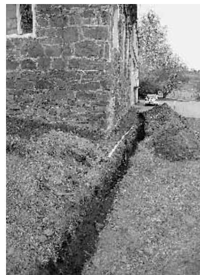
Obr. 6: Celkový pohled na kontrolovaný výkop od jihu. Foto autor
