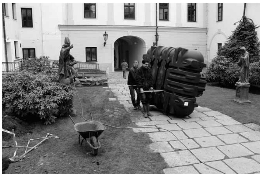
Stěhování plastového rezervoáru na dešťovou vodu, který je umístěn v zemi na nádvoří muzea. Foto V. Komarová
