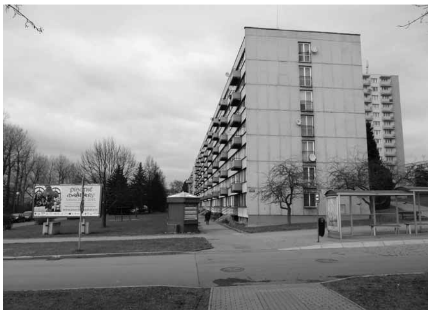
Pohled do míst kde kdysi stával Dobšovský dvůr - na křižovatce ulic Erbenova a Nábřeží 1. máje. Foto J. Adámek
