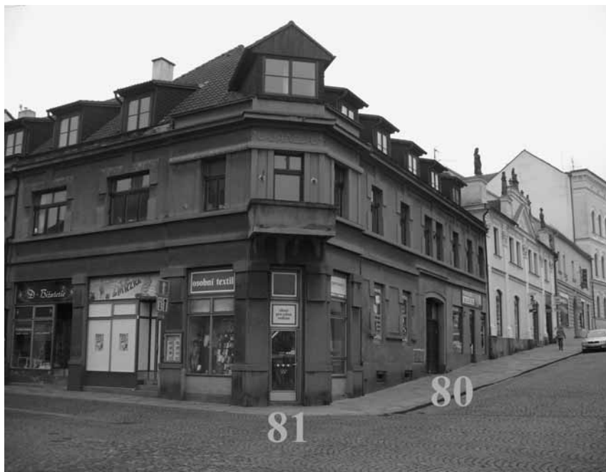
Obr. 1: Dnešní stav nárožního domu čp. 80 na rohu Nerudovy a Smetanovy ulice. Čísla označují původní polohu domů čp. 80 a 81. Ve Smetanově ulici k domu čp. 80 zprava přiléhají domy čp. 79 a 78. Foto J. Pešta
