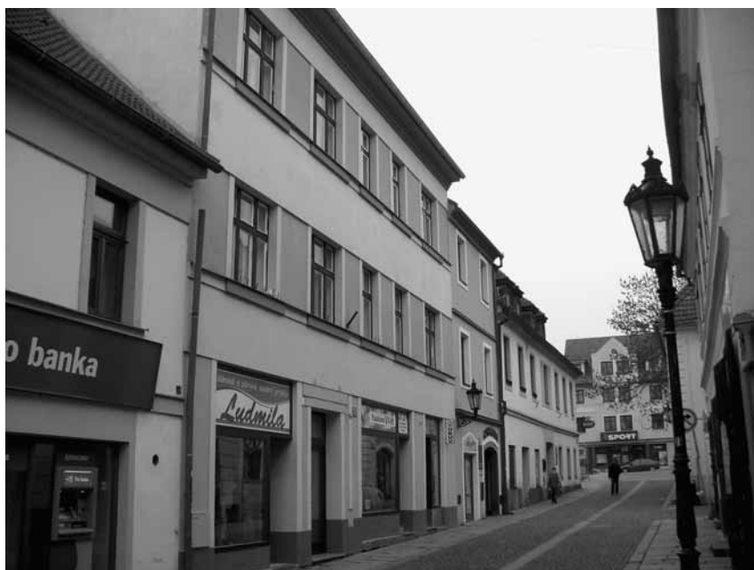
Obr. 16: Část severní fronty dnešní Nerudovy ulice. Odleva část domu čp. 88, dále průčelí domů čp. 163 (vznikl rozdělením domu čp. 68), 67 a 66. Foto J. Pešta
