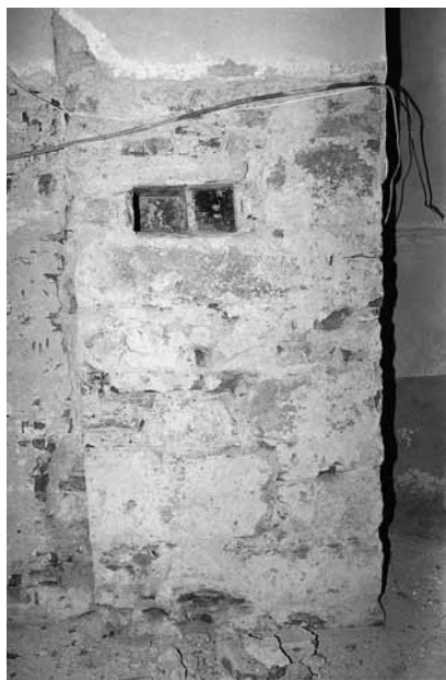
Detail spodní části jižního polopilíře někdejšího triumfálního oblouku s dvojicí otvorů po vsazených trámčích, nesoucích kdysi řečiště kazatelny; stav po odkrytí v roce 1996. Foto V. Komasová
