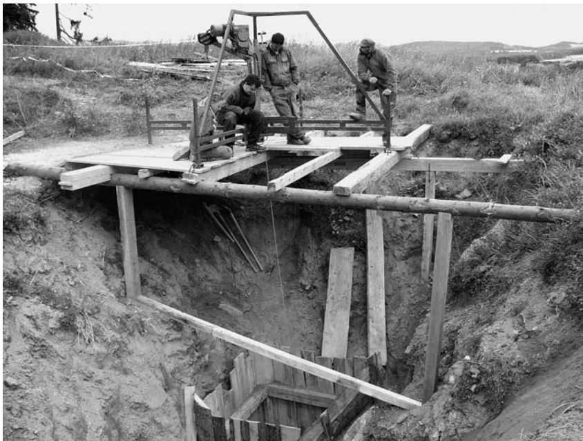
Hloubení šachtice při průzkumu krasu u Bližné. Foto F. Krejča
