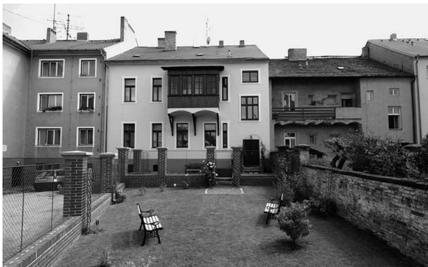
Pohled od západu s částečně obnovenou zahradou v popředí. Foto V. Komarová
