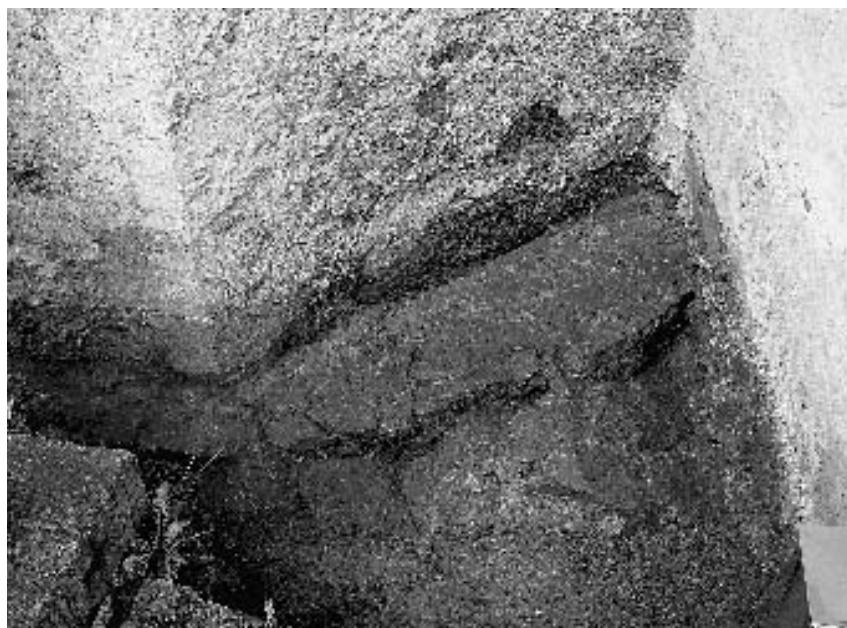
Pohled do části sondy mezi východoseverovýchodním nárožím presbyteria a starou sakristií. Foto J. Adámek
