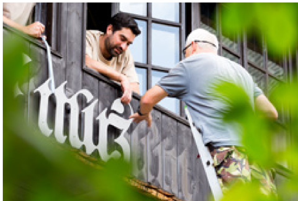
Instalace nového nápisu na pavlánu muzea.
