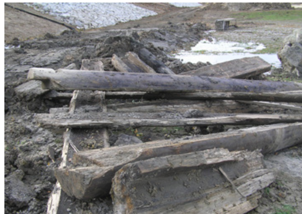
Obr. 2 | Části dřevěného výpustného potrubí z hráze Nádvorného rybníka v Purkraticích u Písku. Foto autor
