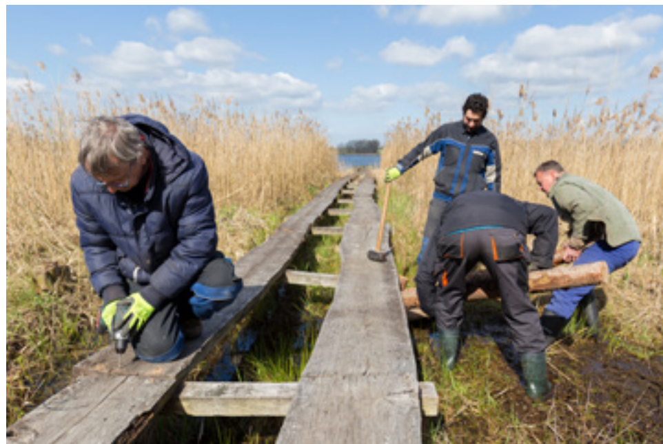
Budování lávek na Řežabinci.
