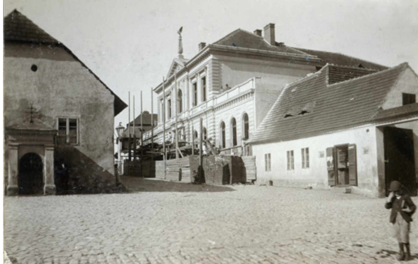
Pověsti č. 12–15 | Snímek ze stavby sokolovny z roku 1895. Napravo v popředí Žardonka čp. 66, nalevo Sepekovská kaplička.
