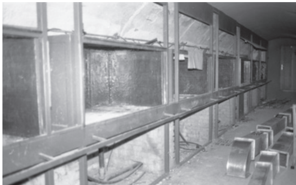
Obr. 7 | Stavba nových nádrží v roce 1994. — Archiv Prácheňského muzea
