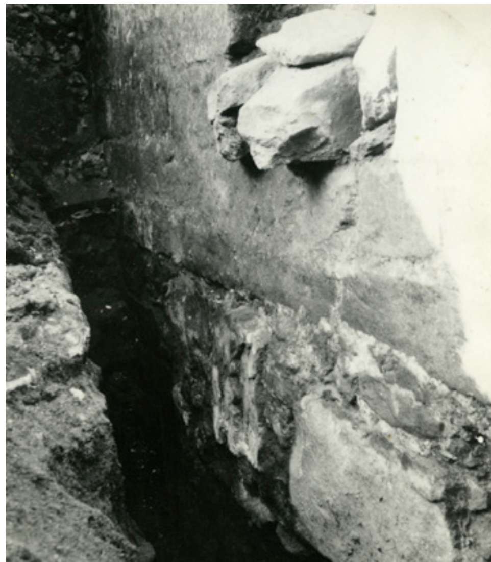
Obr. 15 | Detail kvádrové návodní zdi mostu s druhotným narušením (nahore). Nepořádněji provedené zdivo dole může být stopou jejich pozdějších úprav. Foto Archeologický ústav AV ČR, archiv, negativ č. 38515, zde publikován snímek z archivu archeologického oddělení Prácheňského muzea.
