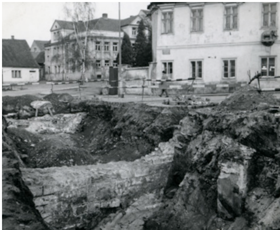
Obr. 14 | Pokračování návodní stěny mostu, odhalené při záchranném výzkumu Jaroslava Kudrnáče v roce 1967. Za ní je patrné světlé zdivo další odkryté zdi. Foto Archeologický ústav AV ČR, archiv, negativ č. 38503, zde publikován snímek z archivu archeologického oddělení Prácheňského muzea.
