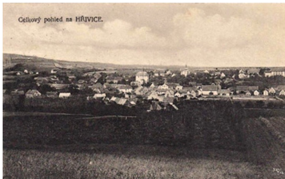
Pověst č. 20 | Ves Hřivice na pohlednici z roku 1922, napravo nahoře dvůr čp. 1, kde sloužila Marie Axamitová
