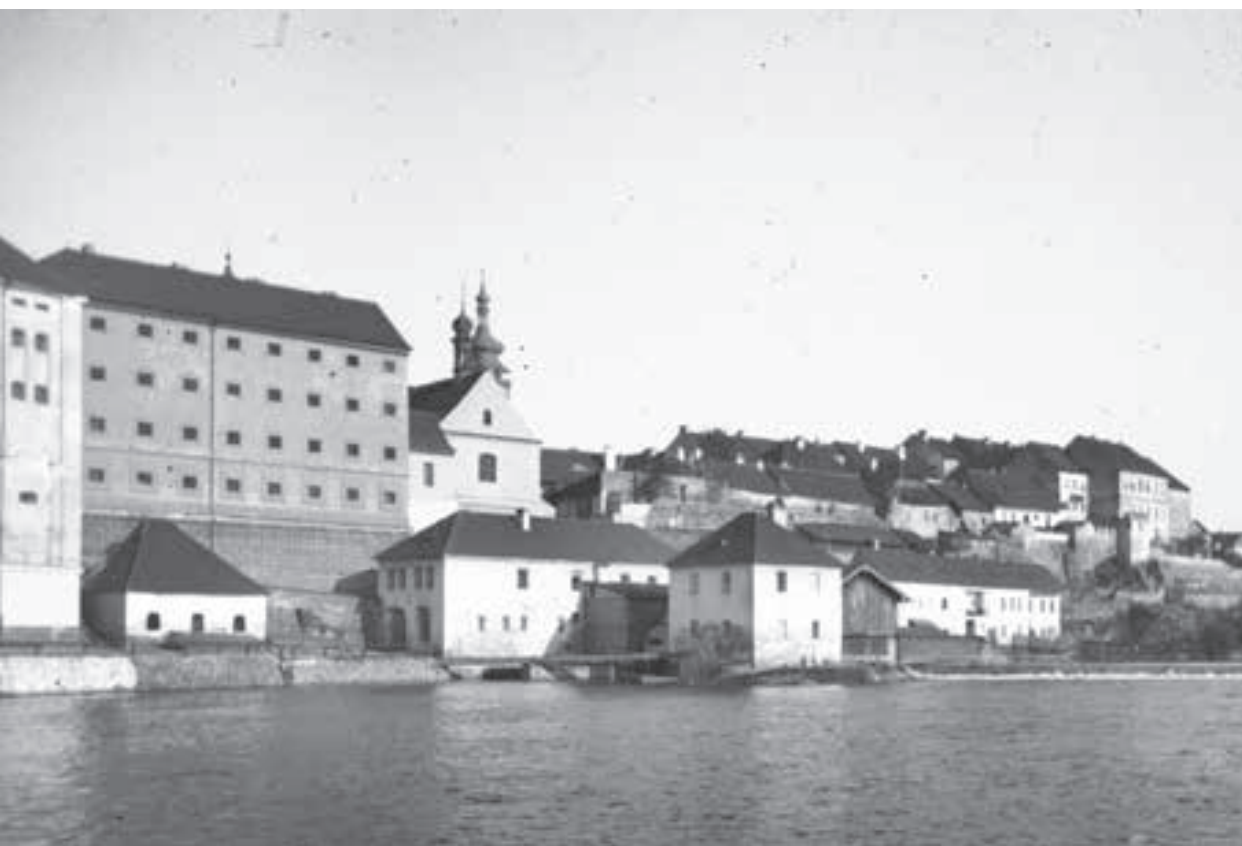
Obr. 8: Fotografie Podskalského mlýna s vodárnou (objekt na ostrově mezi řekou a mlýnským náhonem). Nad ústím náhonu dobře viditelné dřevěné vantroky, ve kterých se ukrývalo hlavní potrubní vedení vody do města. — Prácheňské muzeum v Písku, fotodokumentace, neg. 914.
