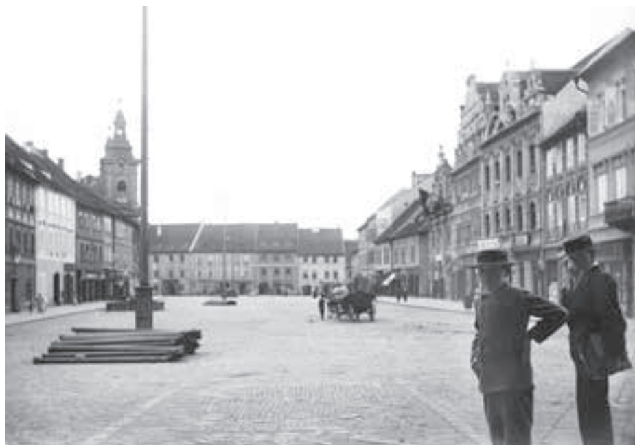
Obr. 15 | Poslední dny starého vodovodu. Na Velkém náměstí uloženy hromady litinových rour, patrně určené k pokládce nového vodovodu. Za sloupem obloukové lampy patrná Neptunova kašna. Chlapci v popředí snímku stojí před budovou hejtmanství (dnes na jejím místě Komerční banka). V dlažbě patrné písmeno „S“ s baronskou korunkou umístěné zde z vděčnosti na památku krajského hejtmána Josefa Schrenka na Notzingu a Egmatingu. Srov. Jaromír MALÝ, Paměti prof. Karla Níngra. Písecké vzpomínky , Písek 1932, s. 69 a 198.
