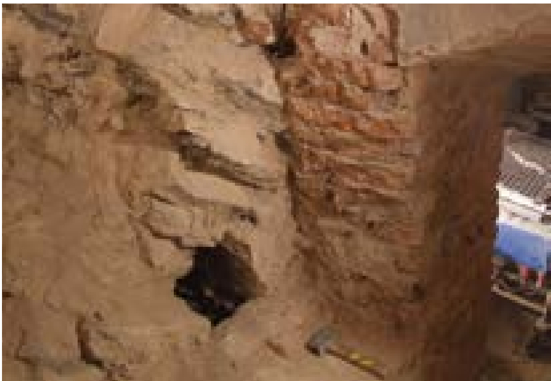
Obr. 4 | Dokumentace zdiva na přístupovém schodišti do suterénu domu čp. 118. Foto J. Jiřík.
