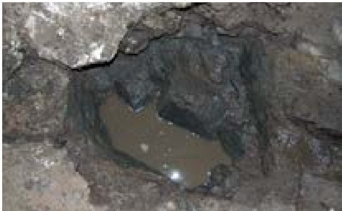
Obr. 10 | Dokumentace jímky v suterénu domu čp. 118 v roce 2008. Foto J. Jiřík.
