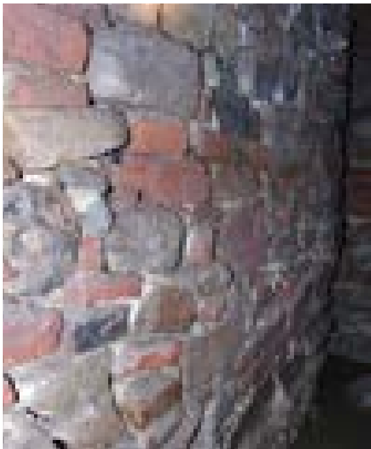
Obr. 6 | Přepážka v jižní stěně lochu vyzdělána ze smíšeného zdiva. Foto J. Jiřík.
